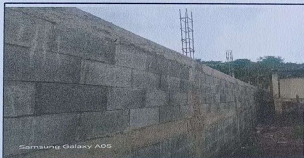
Foto 5: Mejoramiento de Muro Perimetral
