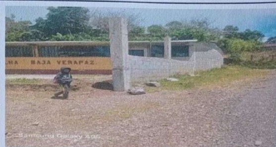
Foto 2: Mejoramiento de Muro Perimetral
