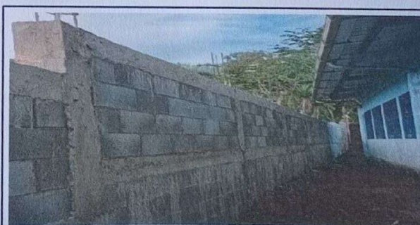
Foto 6: Mejoramiento de Muro Perimetral
