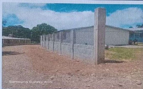
Foto 3: Mejoramiento de Muro Perimetral
